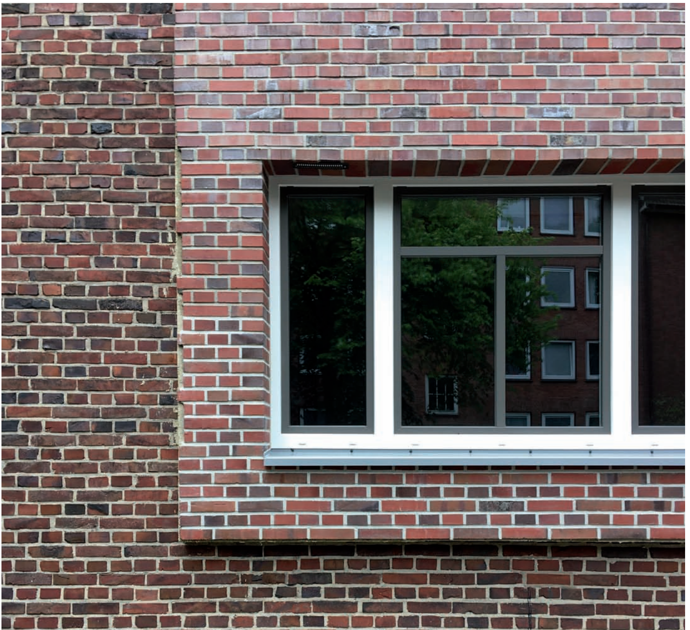
Bild 03: Musterfassade am Wohnblock Heidhörn, Sanierung der historischen Fassade mit Klinkeriemchen und Kunststofffenstern - gelungener Kompromiss ?
